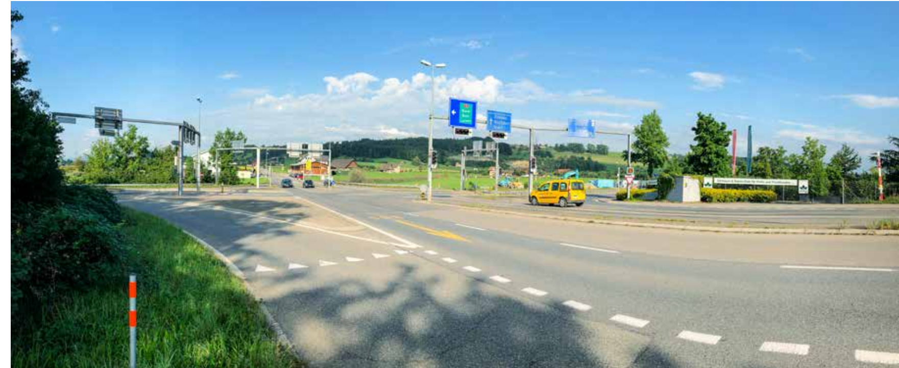
Während der Bauzeit von Januar 2020 bis Dezember 2021 wird der Verkehr beim Knoten Nussbaum über einen provisorischen Kreisverkehr geführt.
