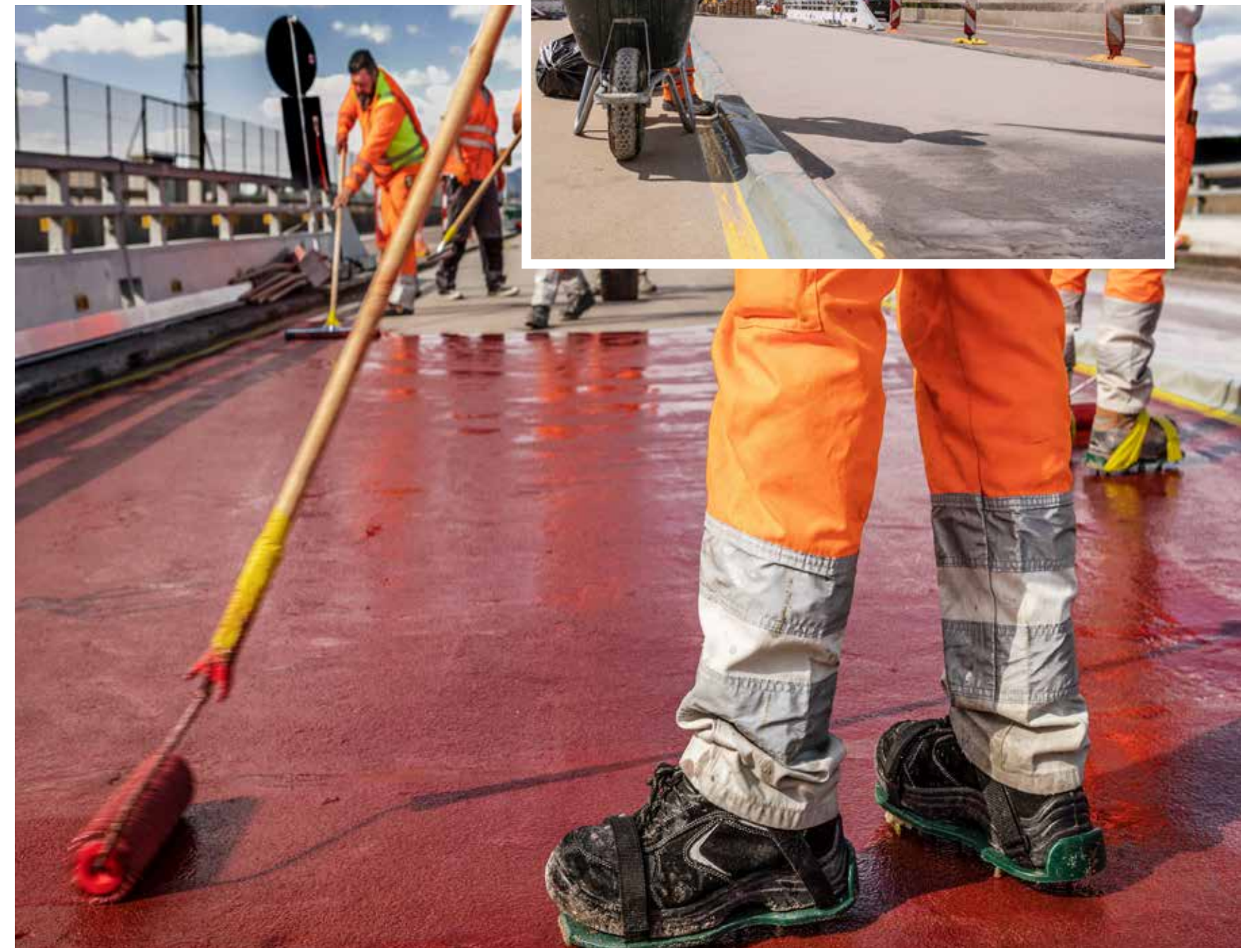
Der Haftvermittler für den Strassenbelag dient gleichzeitig als Decksiegel über den Dilatationsfugen.
