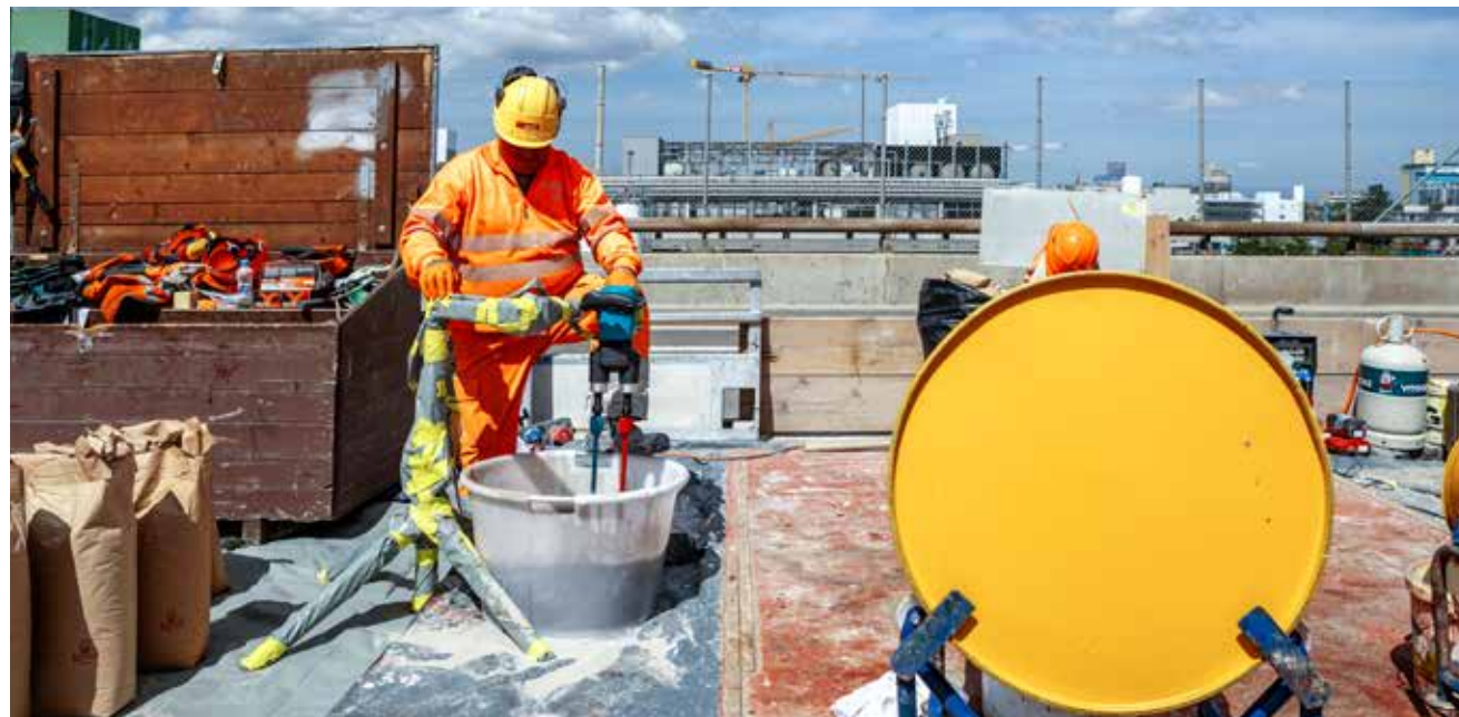
Feinarbeiten werden sorgfältig von Hand erledigt.
