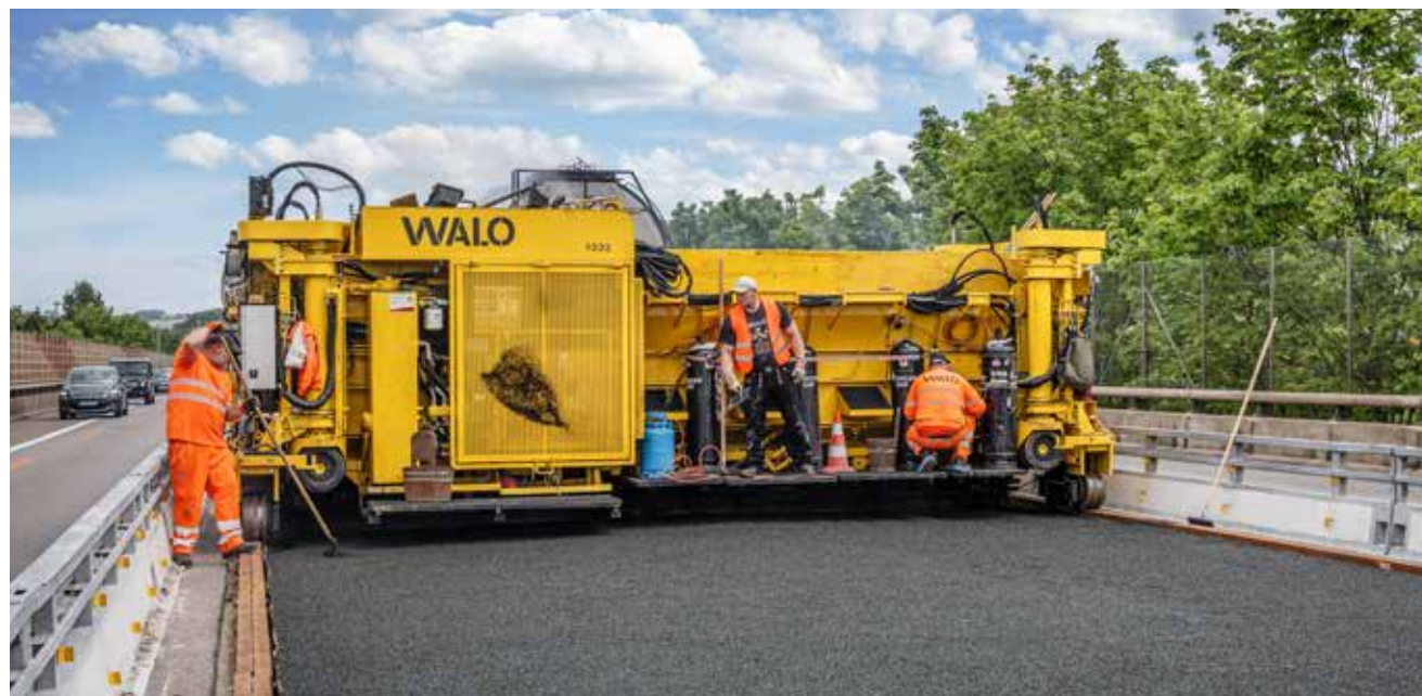
Der neue Strassenbelag wird wenn möglich auf der ganzen Breite in einem Zug eingebaut.
