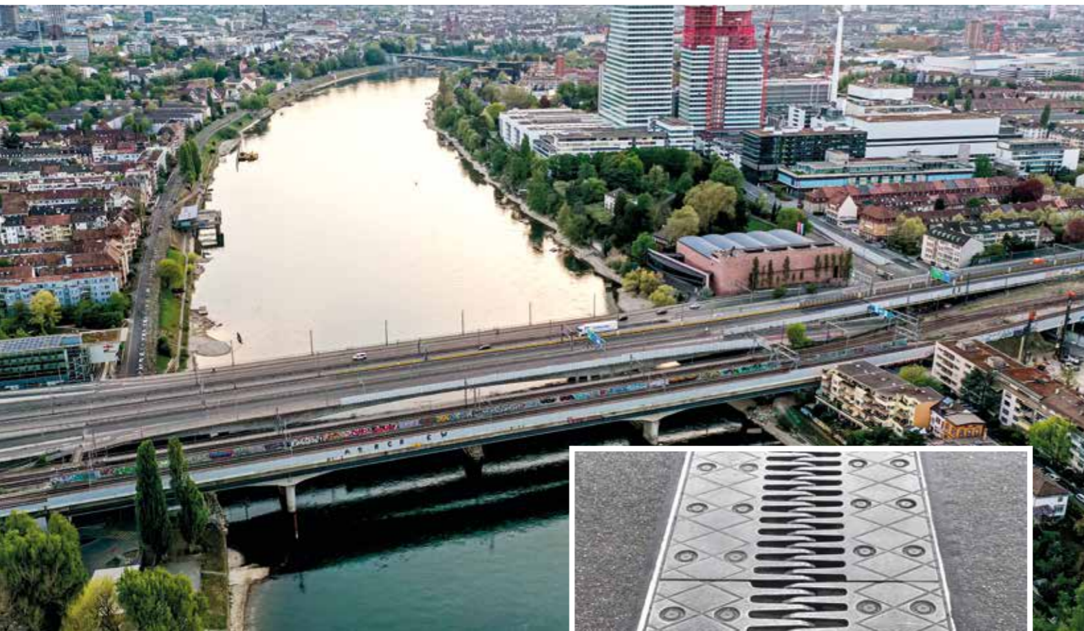
Die Schwarzwaldbrücke in Basel wurde in den Jahren 1971 bis 1973 gebaut.
