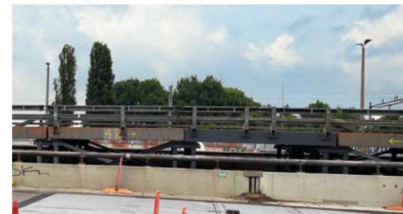
Der Fly-Over überbrückt die Fahrbahnübergänge auf der Schwarzwaldbrücke, sodass darunter weitergearbeitet werden kann.
