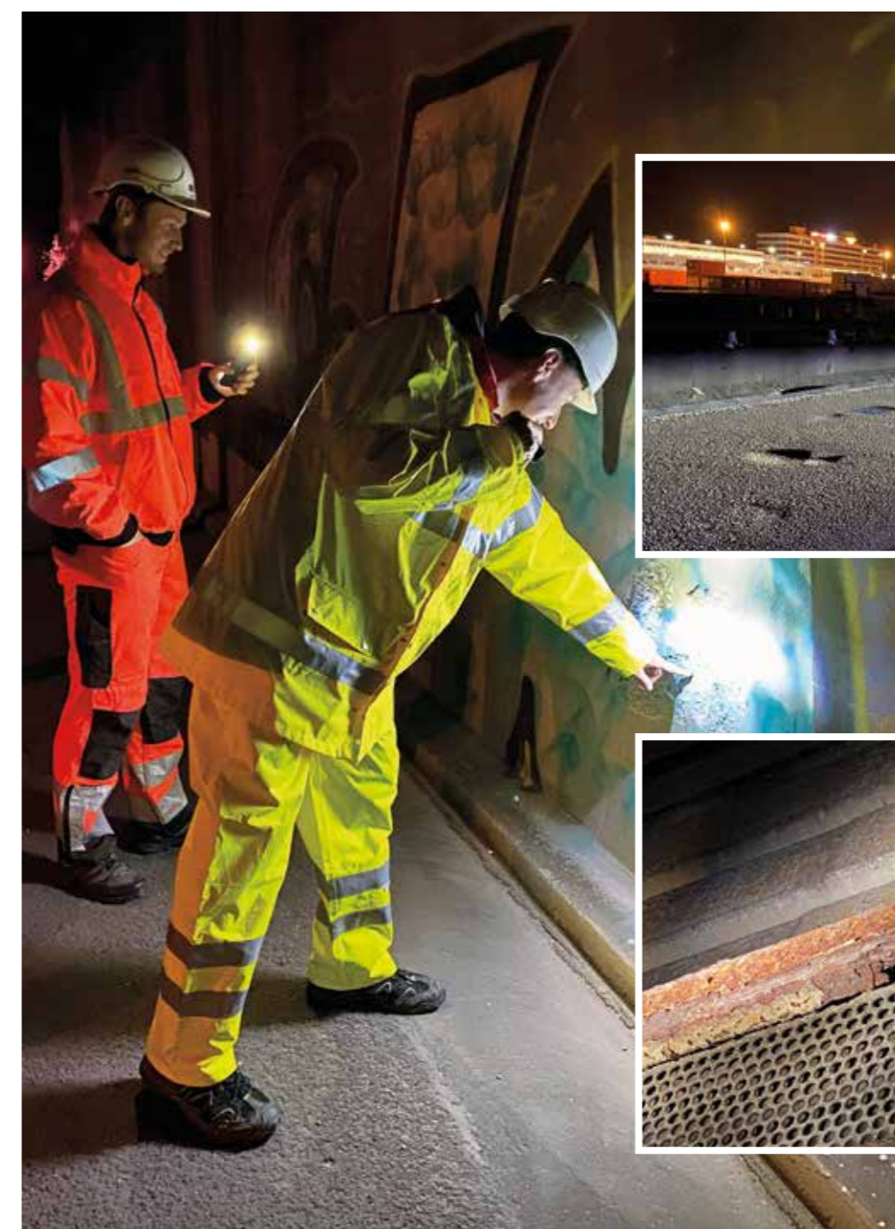
Die Bauingenieure nehmen eine Stelle in Augenschein, wo der Beton abgeplatzt ist.
