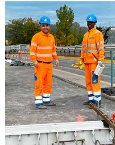
Die Mitarbeitenden auf der Baustelle sind voll motiviert.
