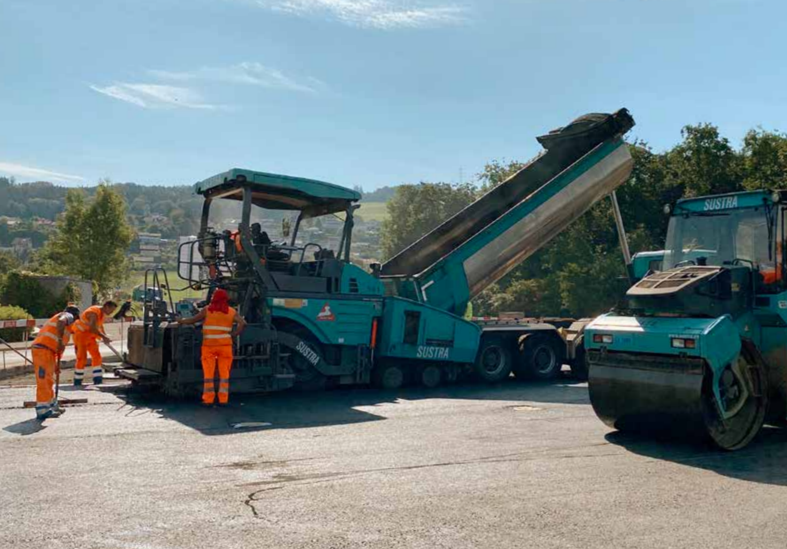
Belagseinbau beim Knoten Nussbaum mit einem Belagsfertiger.
