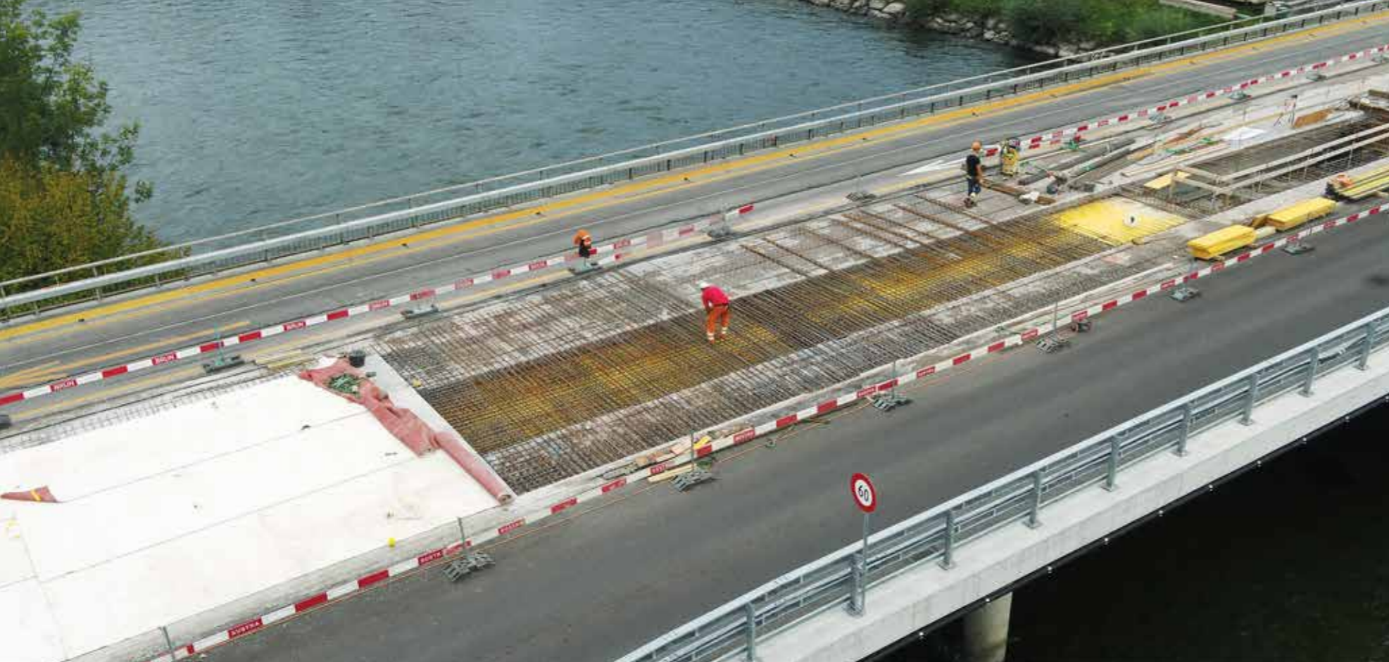
Zusammenschluss der bisher getrennten Brücken über die Reuss beim A14-Anschluss Gisikon Root.
