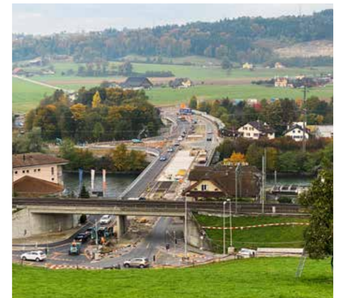
Die Bauarbeiten werden gleichzeitig in verschiedenen Bereichen des Anschlusses Gisikon Root durchgeführt.
